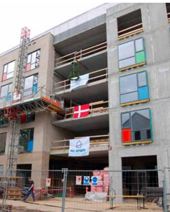
Nye boliger på Rentemestervej
